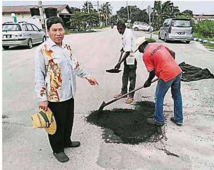
謝耀亮（左）巡視路洞修補工程。
